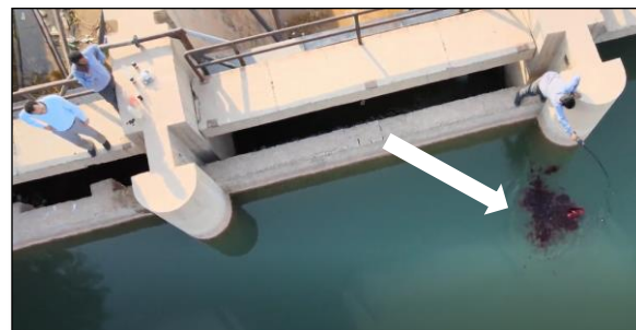
شکل ۱۸. تزریق ماده رنگی به جریان آب جهت بررسی حرکت جریان - کنار دریچه نیروپیک
