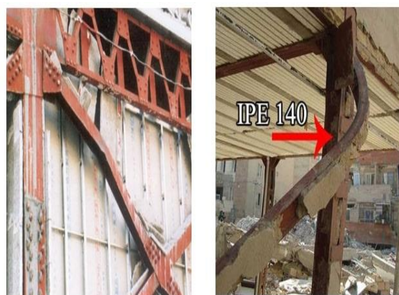
شکل ۷. کمانش خارج از صفحه (سمت راست) و کمانش داخل صفحه (سمت چپ)
