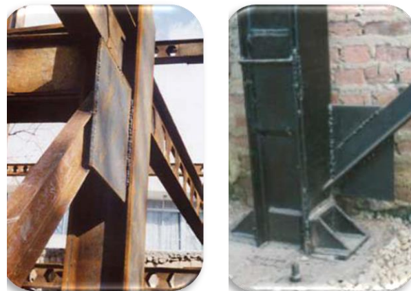
شکل ۱۰. خروج از مرکزیت خارج از صفحه ورق اتصال
