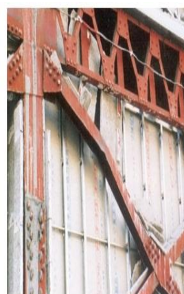
شکل ۷. کمانش خارج از صفحه (سمت راست) و کمانش داخل صفحه (سمت چپ)
