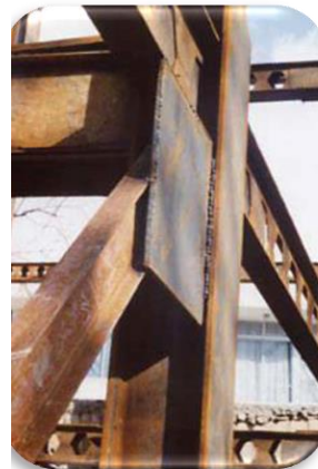
شکل ۱۰. خروج از مرکزیت خارج از صفحه ورق اتصال
