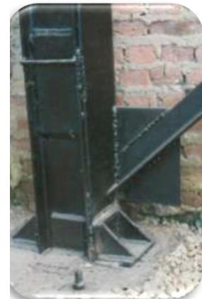
شکل ۱۰. خروج از مرکزیت خارج از صفحه ورق اتصال
