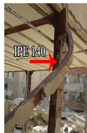
شکل ۷. کمانش خارج از صفحه (سمت راست) و کمانش داخل صفحه (سمت چپ)
